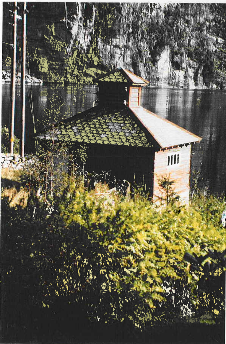
Kraftstasjonen på Nottveit
